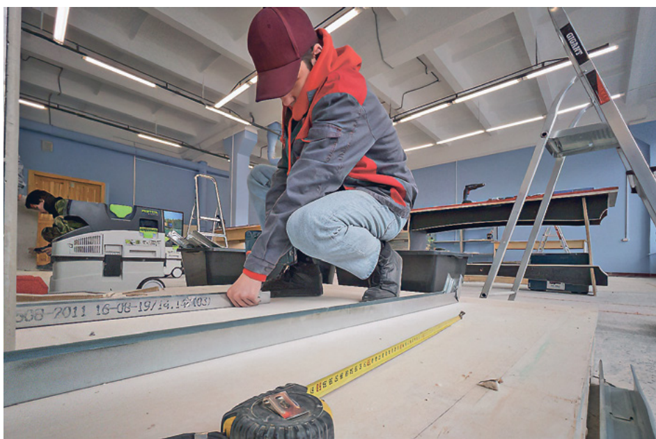
Мастерские в Архангельском техникуме строительства и городского хозяйства оснащены современным оборудованием
