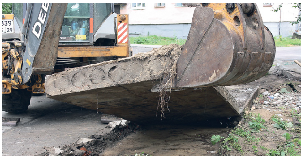
Начался временный демонтаж контейнерной площадки
